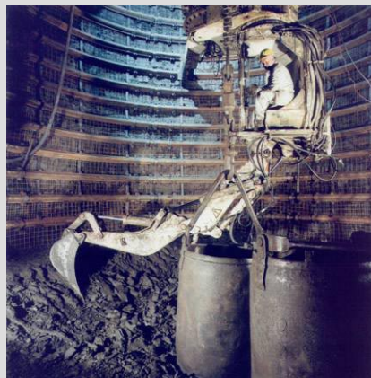
Figure 3.28 Creusement du deuxième puits. Creusement de l'amorce de la galerie de liaison (en haut) et bras hydraulique et cintres métalliques coulissants (en bas).
