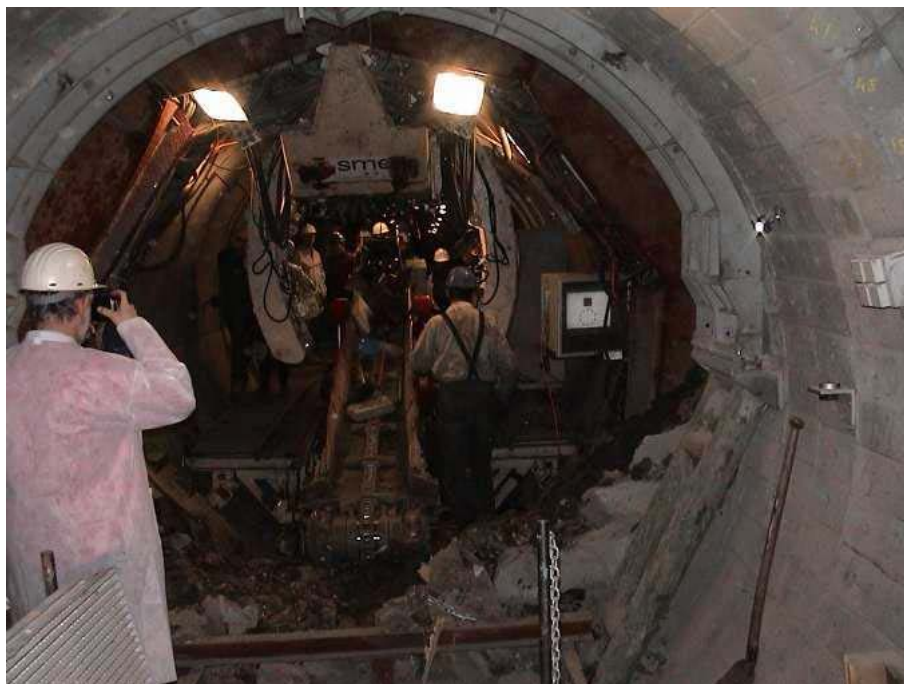
De doorbraak: aankomst van de tunnelmachine aan het bestaande laboratorium HADES.
