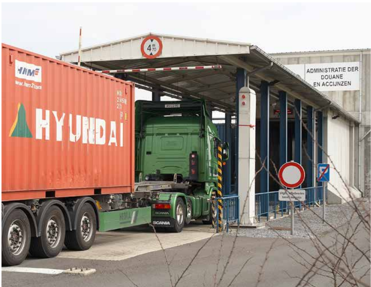
Le portique est composé de détecteurs de radiations verticaux placés des deux côtés de la voie empruntée par les véhicules qui pénètrent sur le site.
