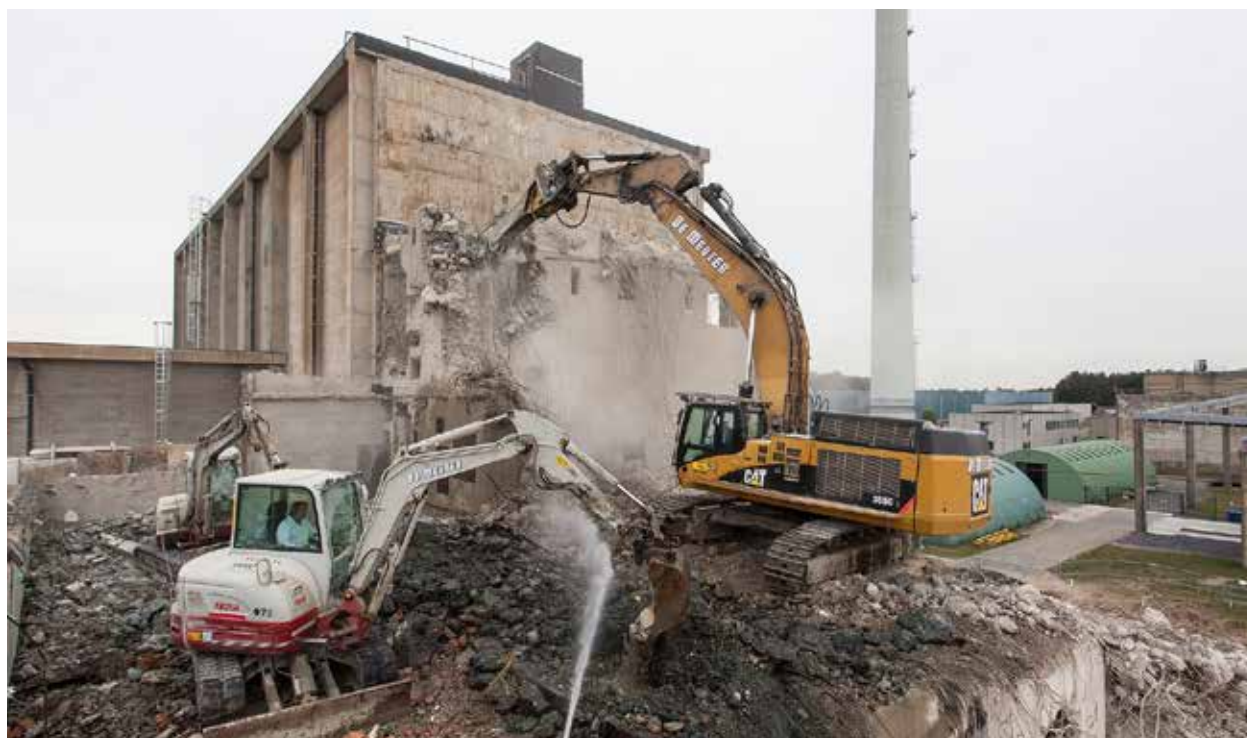
L'usine Eurochemic est à présent totalement démolie.
