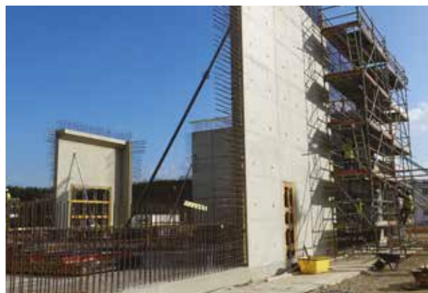
Bouwplaats van de IPM
