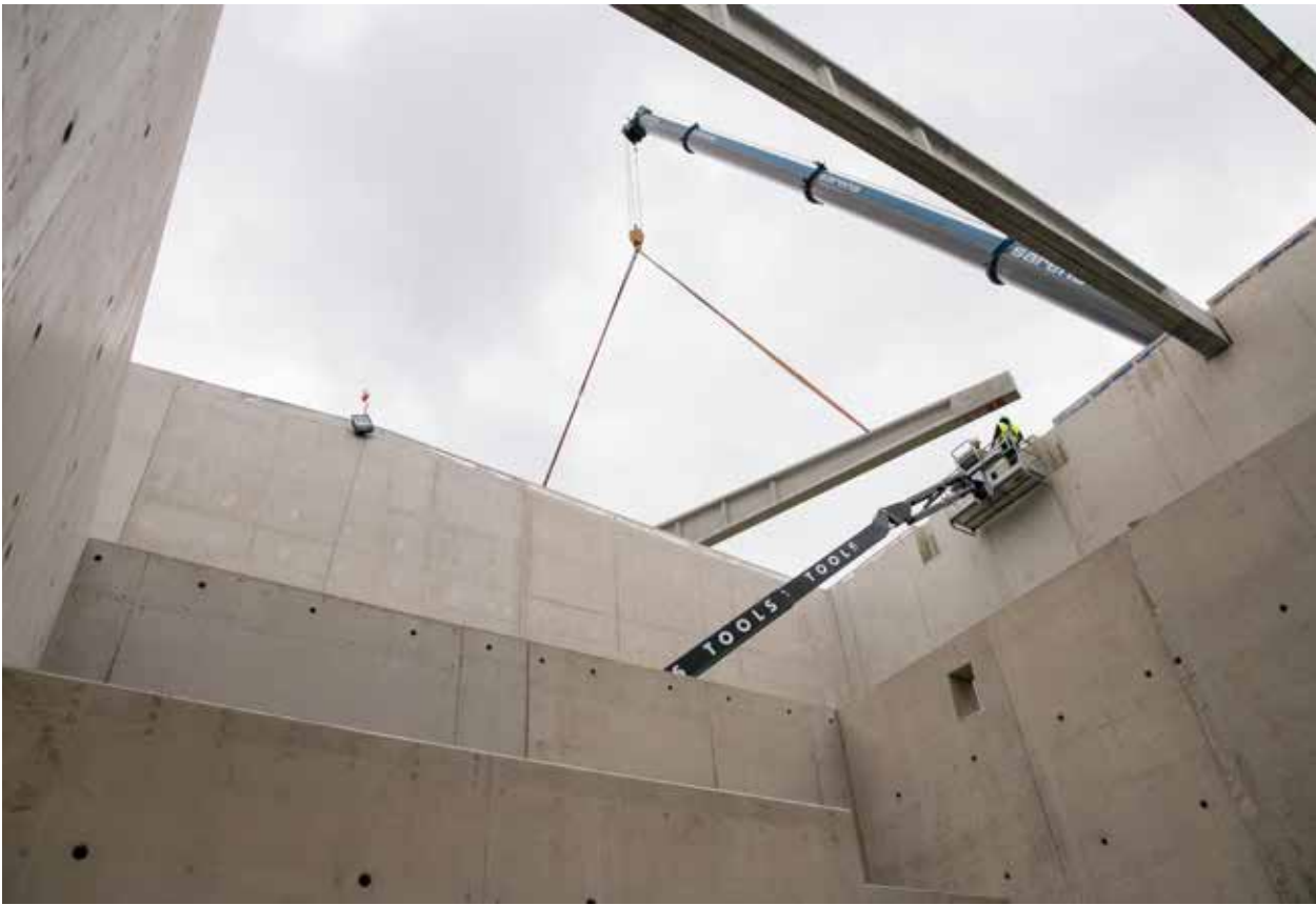
La construction des installations s'accompagne de travaux minutieux.
