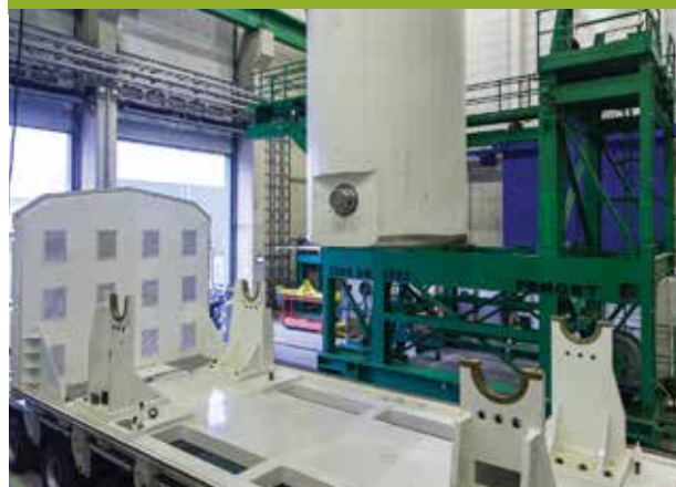
Ontlading van de transportverpakking in het opslaggebouw
