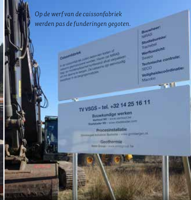
De eerste muren van het toegangsgebouw staan al recht.
