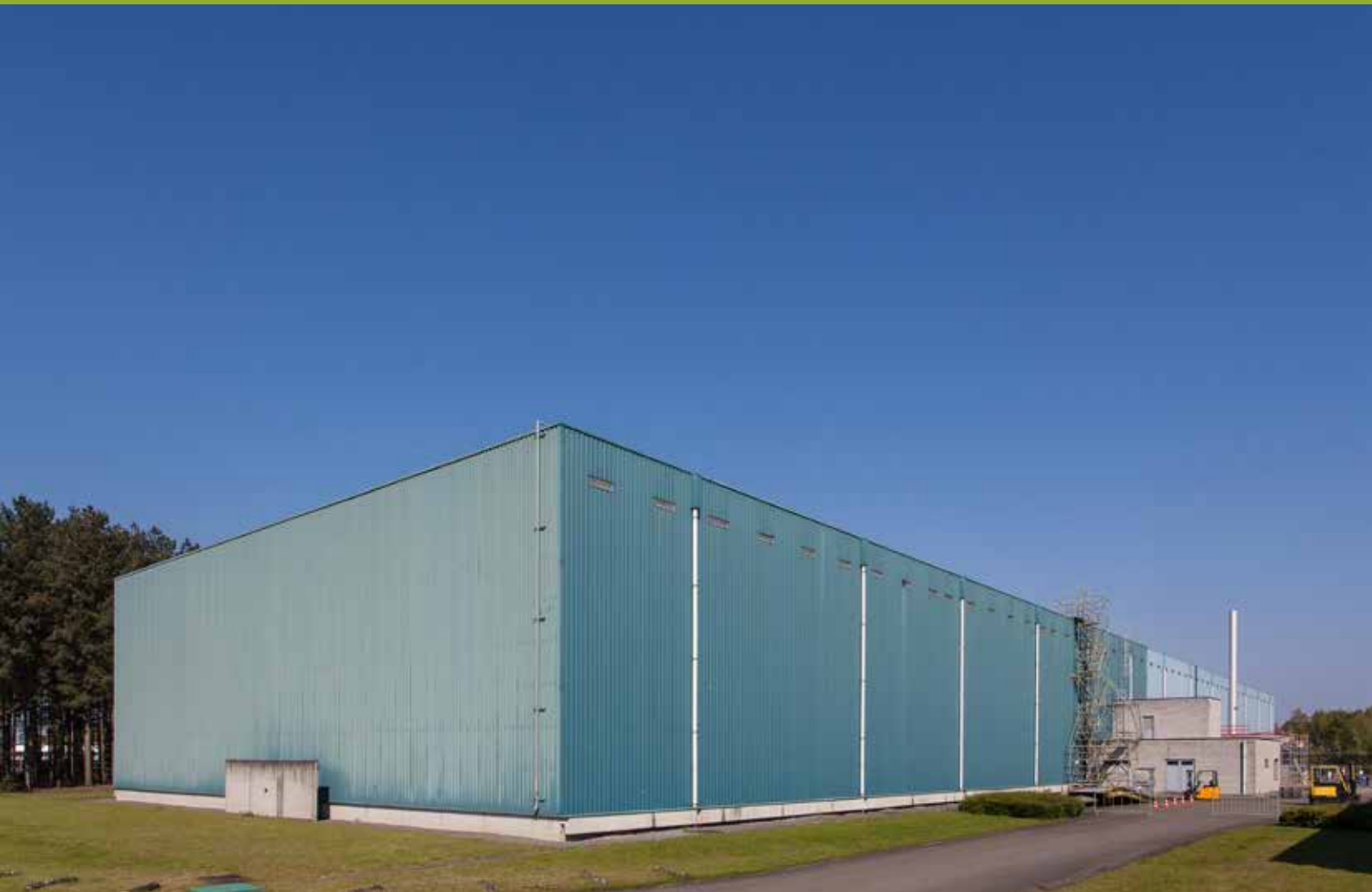
Het Belgische radioactieve afval wordt opgeslagen in aangepaste opslaggebouwen bij Belgoprocess in Dessel.
