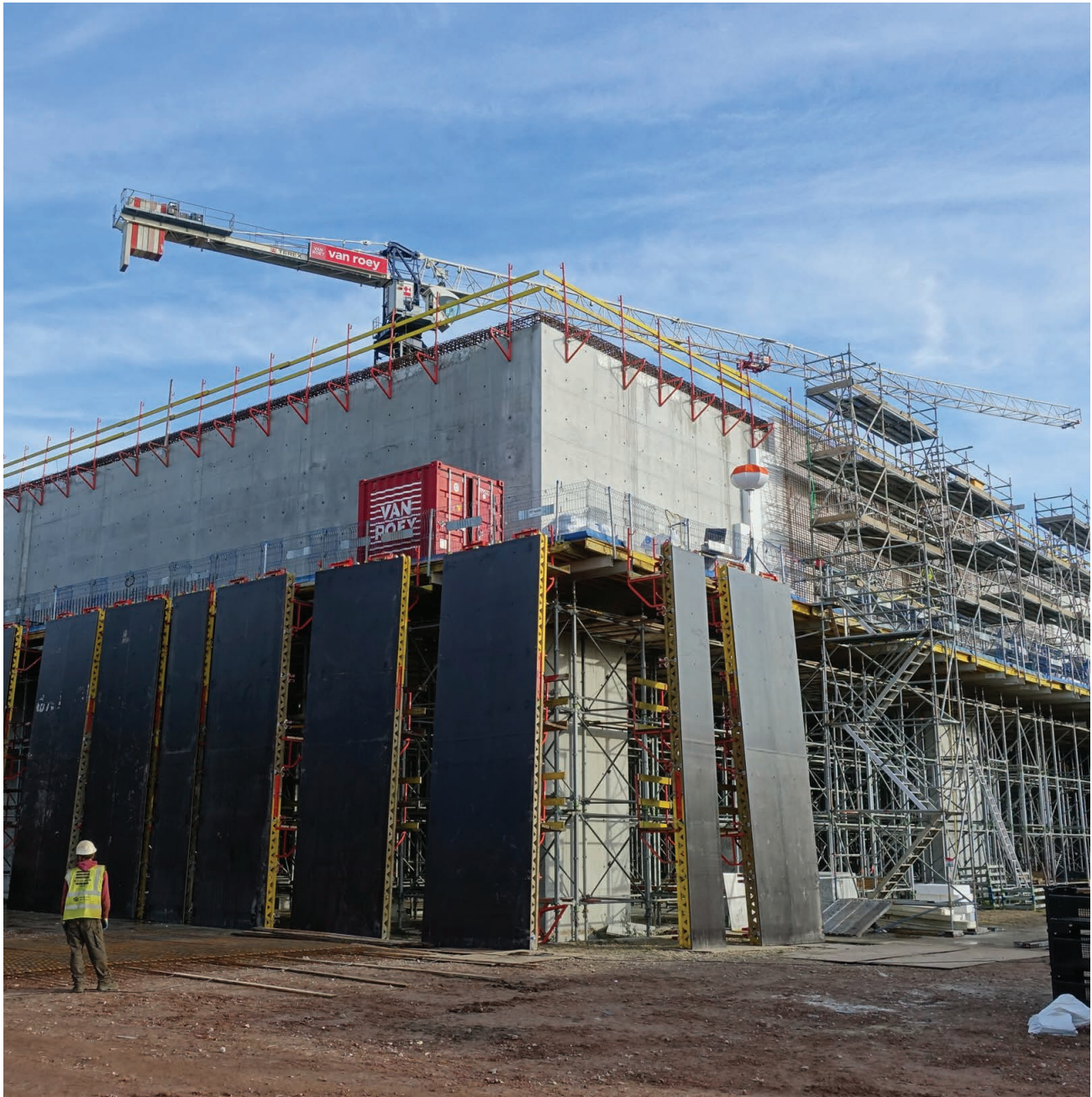
Aanzicht van de bouwplaats van Tabloo
