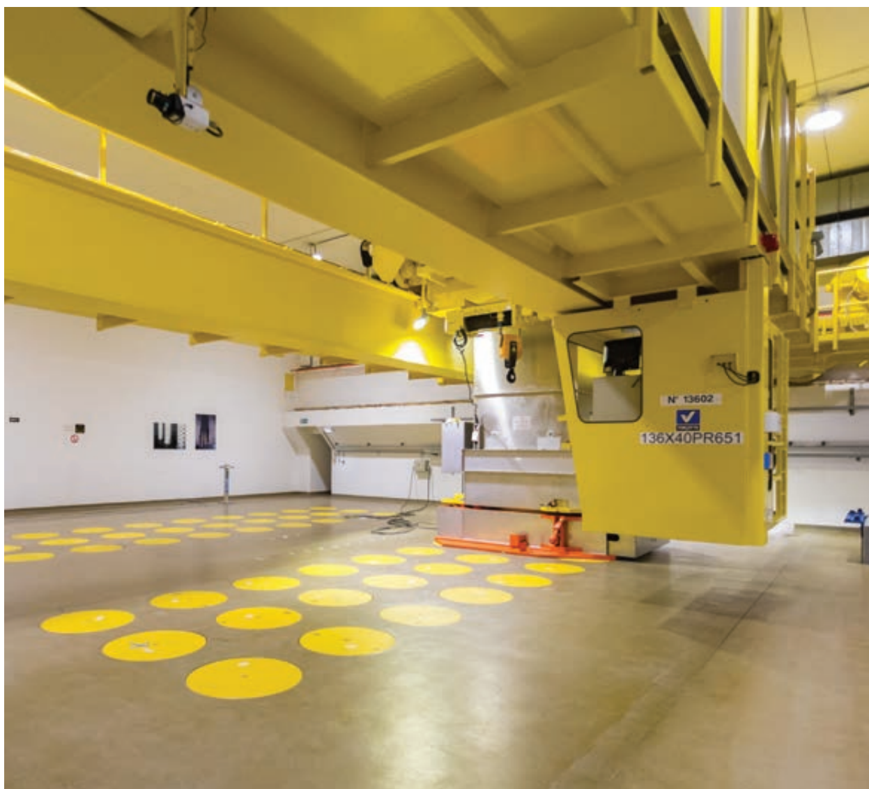
De vaten met verglaasd hoogactief afval worden bewaard in metalen kokers. De gele deksels vormen de bovenste van een driedubbele afsluiting.
