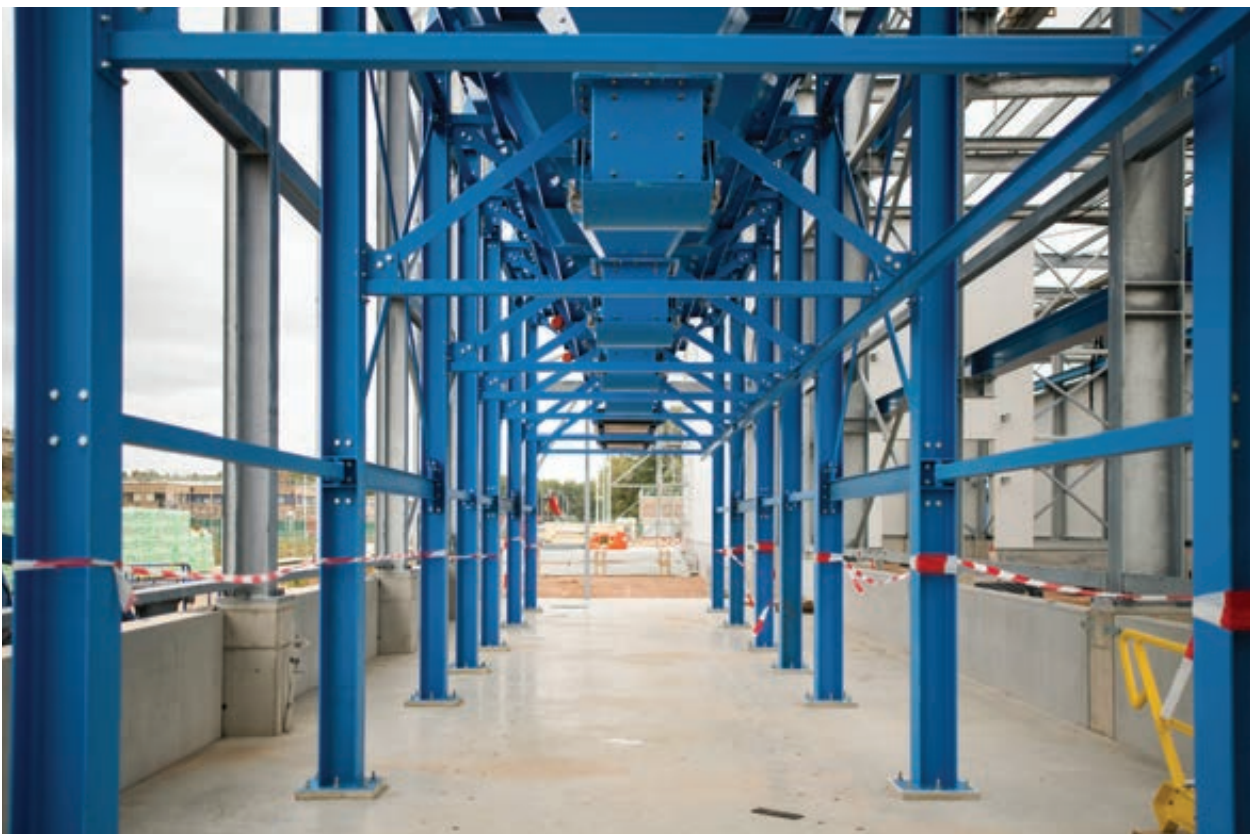
Een blik op de betoncentrale van de caissonfabriek.
