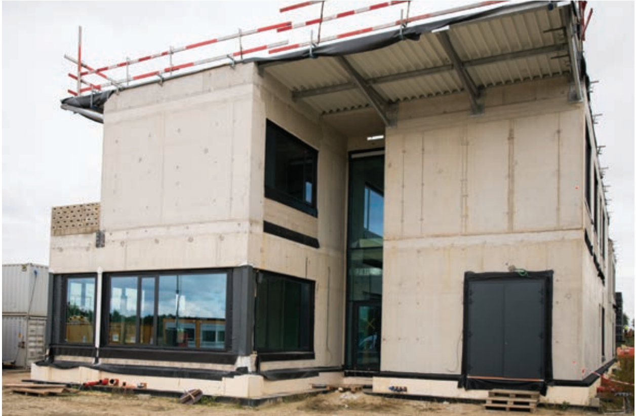
De gebouwen van de toegangscluster, de toegang tot de oppervlaktebergingsite, zullen wellicht als eerste klaar zijn.
