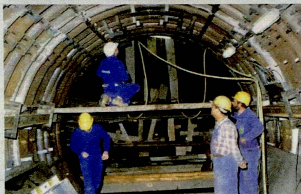
Figuur 3.27 De drie bekledingstypes die tot nog toe werden gebruikt in de ondergrondse galerijen: (a) bekledingssegmenten in nodulair gietijzer (experimentele galerij HADES); (b) betonnen gewelfstenen (kleine galerij en Test Drift); (c) metalen glijprofielen (Test Drift, deel ANDRA).
