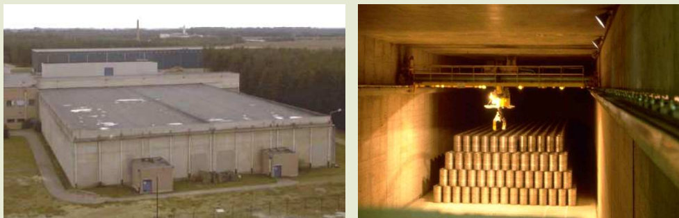
Figuur 15 – Buitenaanzicht van het door Belgoprocess geëxploiteerde gebouw 127 van NIRAS, bestemd voor de opslag van geconditioneerd middelactief afval, en binnenaanzicht van één van de vier bunkers van het gebouw. Het afval wordt behandeld door middel van een rolbrug die vanuit een afzonderlijke bedieningszaal wordt bestuurd (bron: Belgoprocess).
