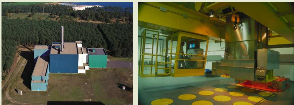
Figuur 16 – Buiten- en binnenaanzicht van het door Belgoprocess geëxploiteerde gebouw 136 van NIRAS, bestemd voor de opslag van geconditioneerd hoog- en middelactief afval. Dit opslaggebouw is ontworpen om te weerstaan aan extreme externe omstandigheden, zoals aardbevingen, ontploffingen of het neerstorten van militaire vliegtuigen. De containers met categorie C-afval, die van op afstand behandeld worden vanuit een afgeschermd bedieningszaal, zijn opgestapeld in silo's uitgerust met een ventilatiesysteem om de afgegeven warmte af te voeren. Voor een container van 450 kg is deze warmte aanvankelijk vergelijkbaar met die van een elektrische huisradiator met een vermogen van 2 000 W (bron: Belgoprocess).
