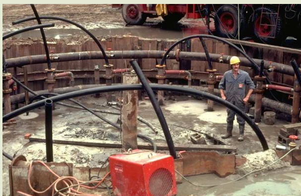
Bevriezing van de grond met het oog op de bouw van de eerste schacht
