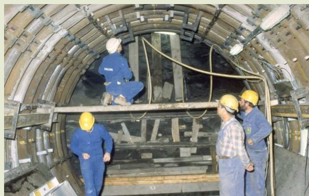
Plaatsing van de bekleding aan het uiteinde van de tweede galerij, de zogenaamde 'Test Drift'
