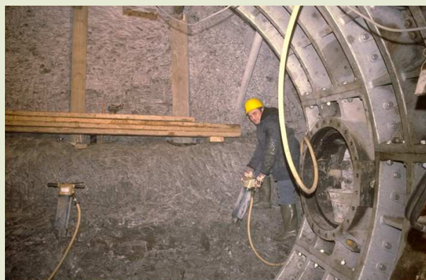
Uitgraving en plaatsing van de bekleding van de eerste galerij van HADES
