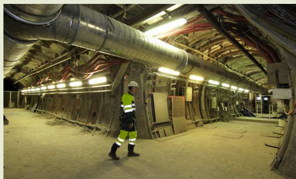
Aanzicht van het ondergronds onderzoekslaboratorium van Meuse / Haute-Marne gebouwd in klei in Frankrijk (bron: Andra).
