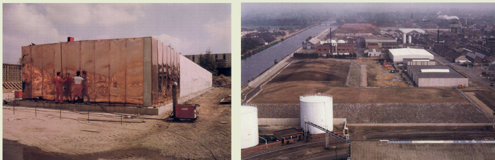
Figuur 48 – De vergunde installatie voor tijdelijke opslag UMTRAP van Umicore in Olen. Links: plaatsing van de koperen insluiting op een betonnen bunker; rechts: algemeen aanzicht van de site na het plaatsen van de deklagen (bron: Umicore).
