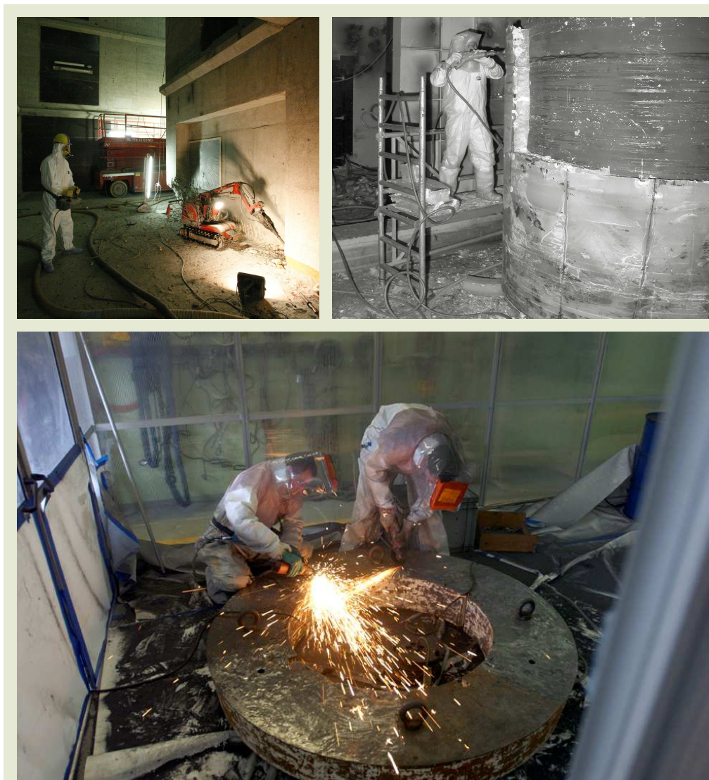
Figuur 19 – Bovenaan: ontmanteling van de proefopwerkingsfabriek Eurochemic (bron: Belgoprocess en Bonsei Publicatiebureau); onderaan: ontmanteling van een stuk van de onderzoeksreactor BR3 (bron: SCK•CEN).
