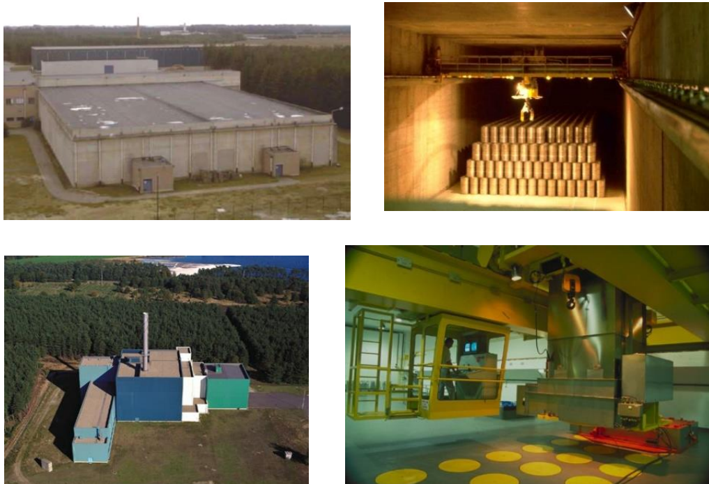
Figuur 12 – Opslag in Dessel. Boven: gebouw 127 voor de opslag van geconditioneerd middelactief afval; onder: gebouw 136, zone-X, voor de opslag van geconditioneerd hoogactief afval.
