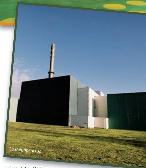
Gebouw 136 in Dessel
