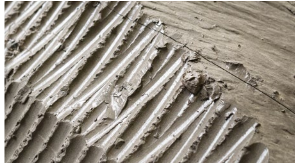
Klei is plastisch. Graafwerken veroorzaken geen blijvende barsten aangezien eventuele scheuren in de klei vanzelf dichtten.
