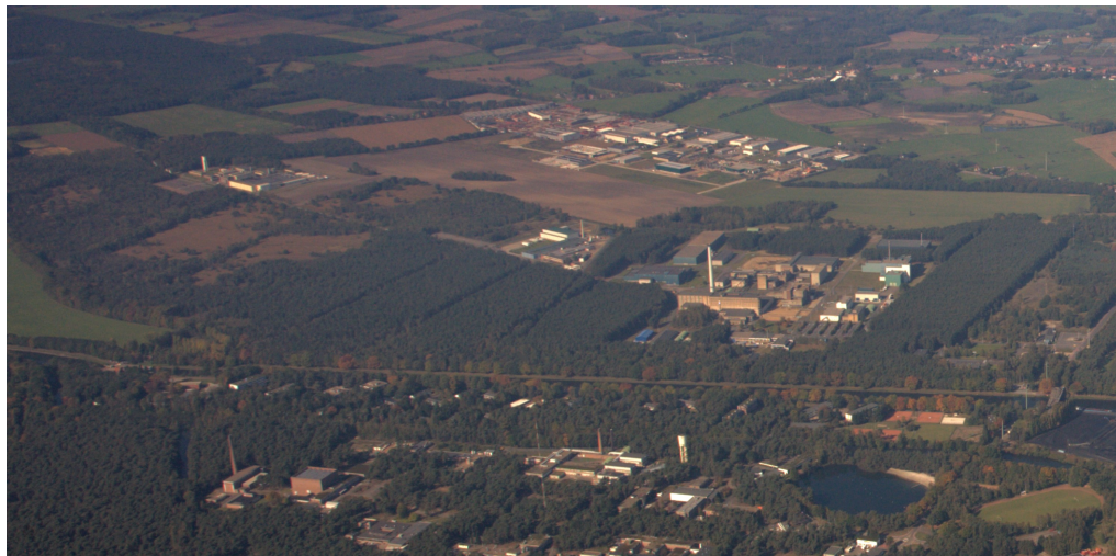
afbeelding 4: luchtfoto van site 1 van Belgoprocess
