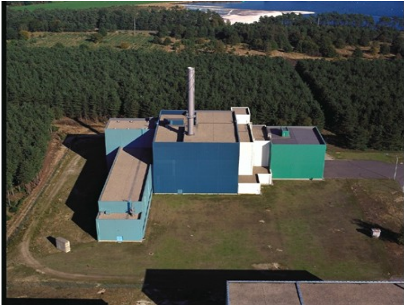
afbeelding 27: buitenaanzicht van gebouw 136: in het groen, de ontvangsthal, in het wit, het sas, in het donkerblauw, de ontladcel, de transferhal en de opslagcel voor verglaasd afval, in het lichtblauw, de transfergang en de opslaghal voor niet-verglaasd afval.
