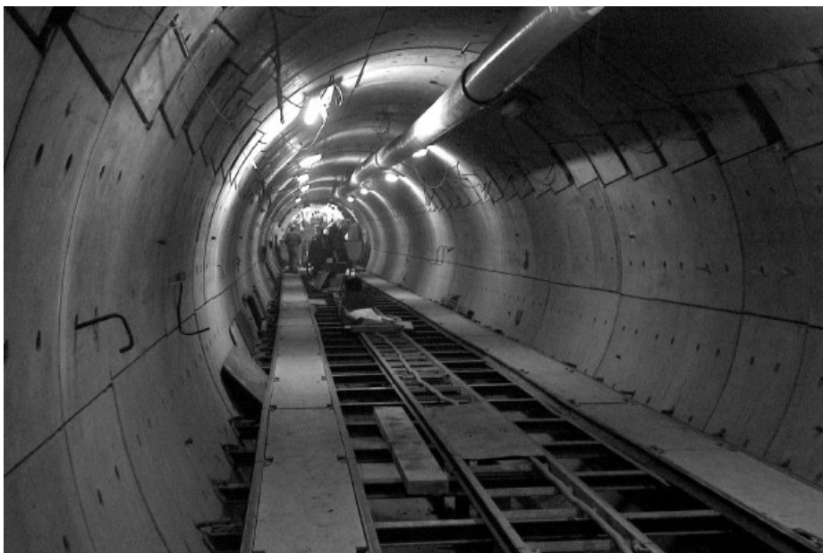
afbeelding 38: algemeen aanzicht van de verbindingsgalerij, gebouwd in 2001–2002, die het bestaande ondergronds laboratorium HADES verbindt met de tweede toegangsschacht.
