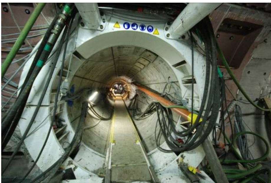
afbeelding 39: aanzicht van de kruising tussen de verbindingsgalerij en de galerij bestemd voor de PRACLAY-test in het ondergronds laboratorium HADES.
