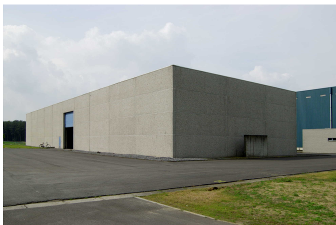
afbeelding 18: buitenaanzicht van gebouw 150
