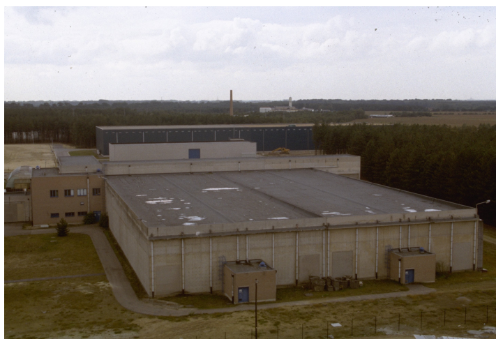
afbeelding 23: buitenaanzicht van gebouw 127
