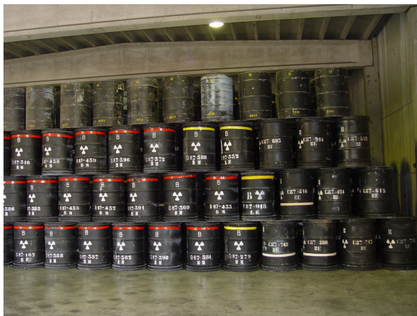
afbeelding 17: binnenaanzicht van gebouw 150
