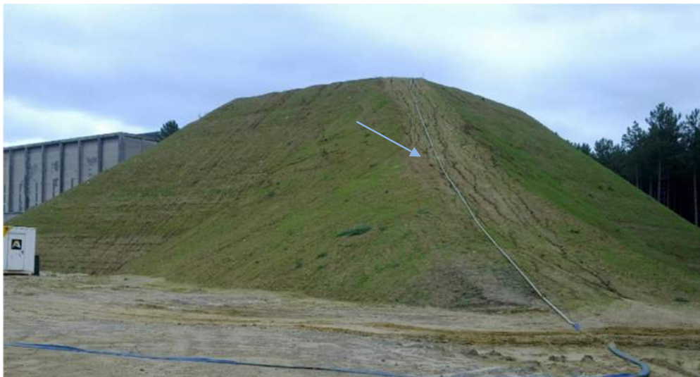
Figuur 4 - 141: Foto van de zettingsproef na afwerking van de vierde fase en na inzaaiing van de flanken om erosie te voorkomen. De aanvoer van het zand gebeurde via een toegangshelling (pijl).
