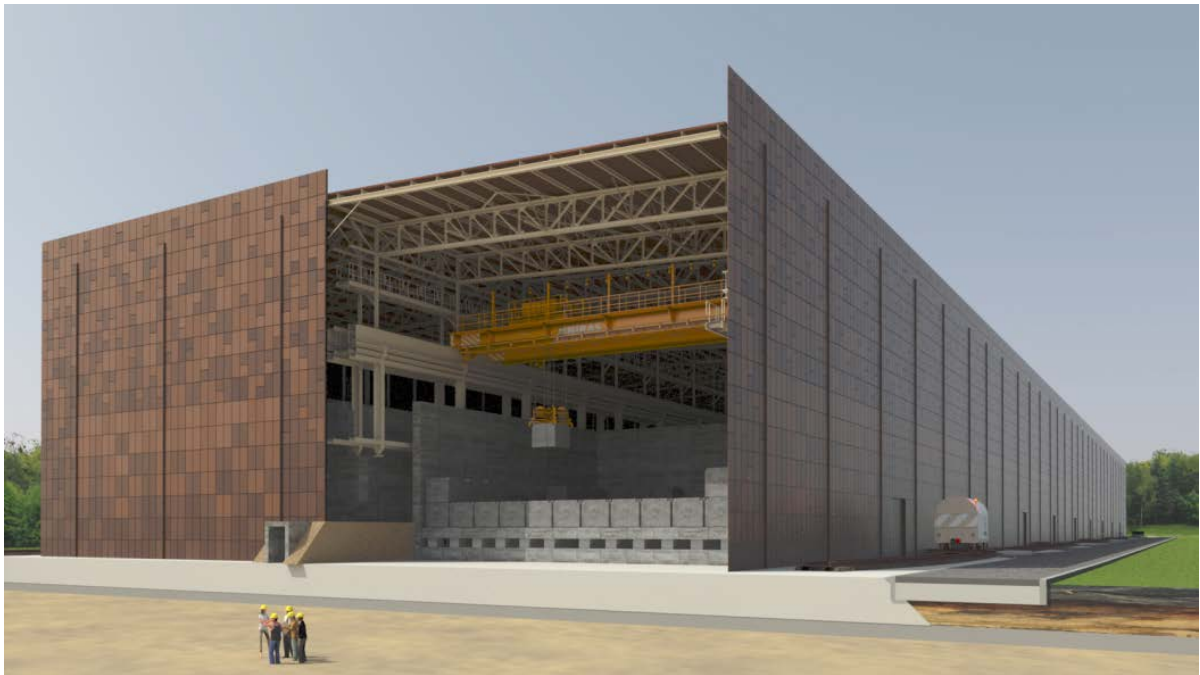
Figuur 8-4: Schets van de bergingsinstallatie waarbij een deel van de componenten weggelaten is om de opbouw van de modules, het vast stalen dak en de manutentiewerktuigen duidelijker weer te geven.
