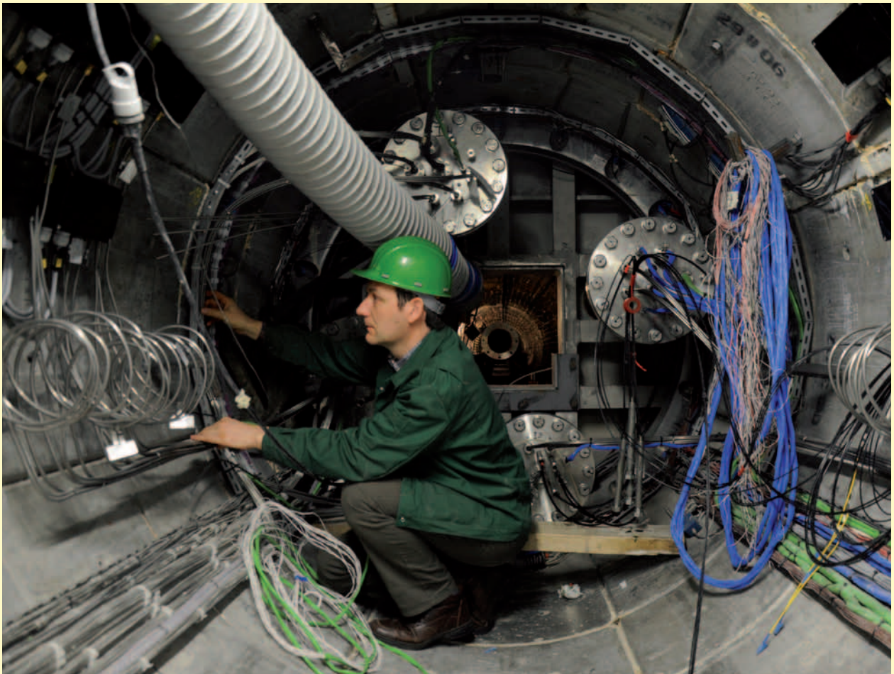
Een onderzoeker controleert de meetinstrumenten ter hoogte van de metalen structuur die de galerij afsluit.
