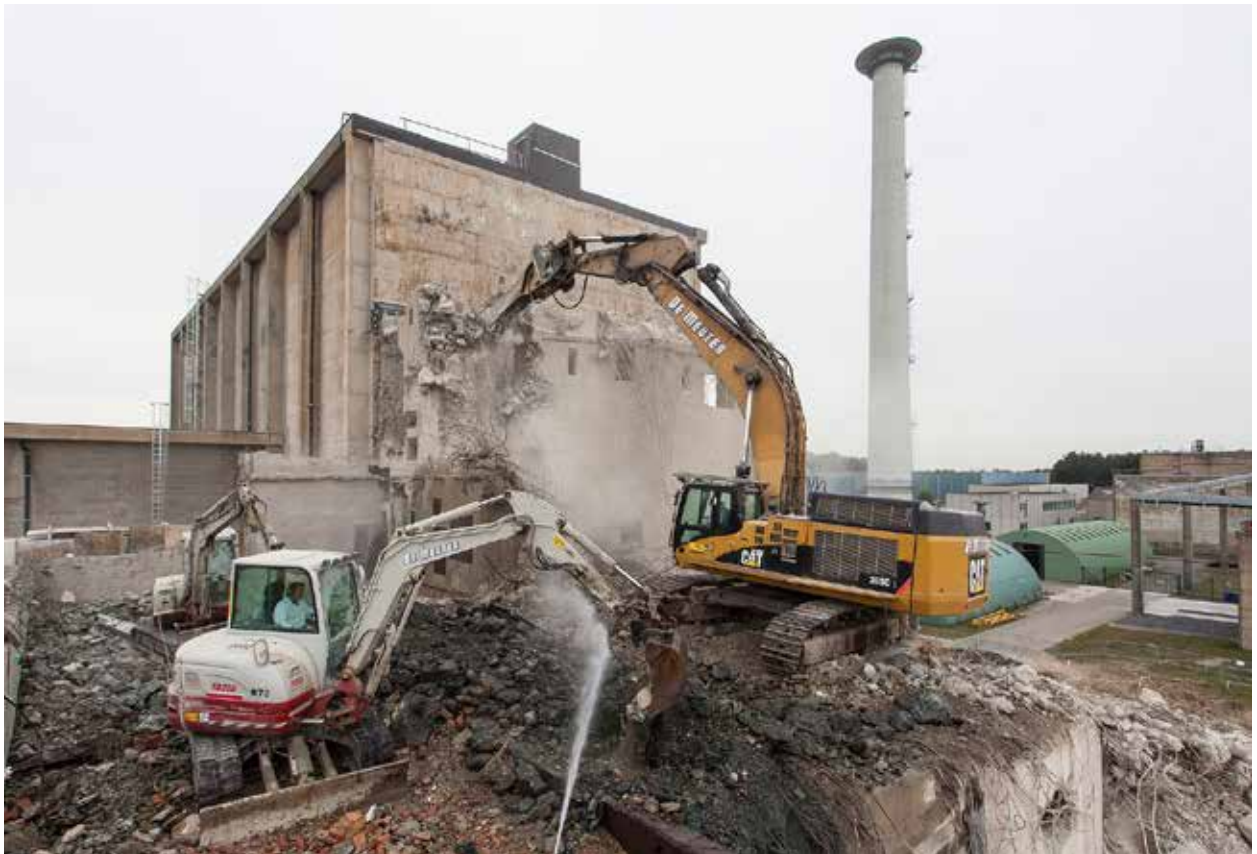
Vandaag is de fabriek van Eurochemic volledig afgebroken.
