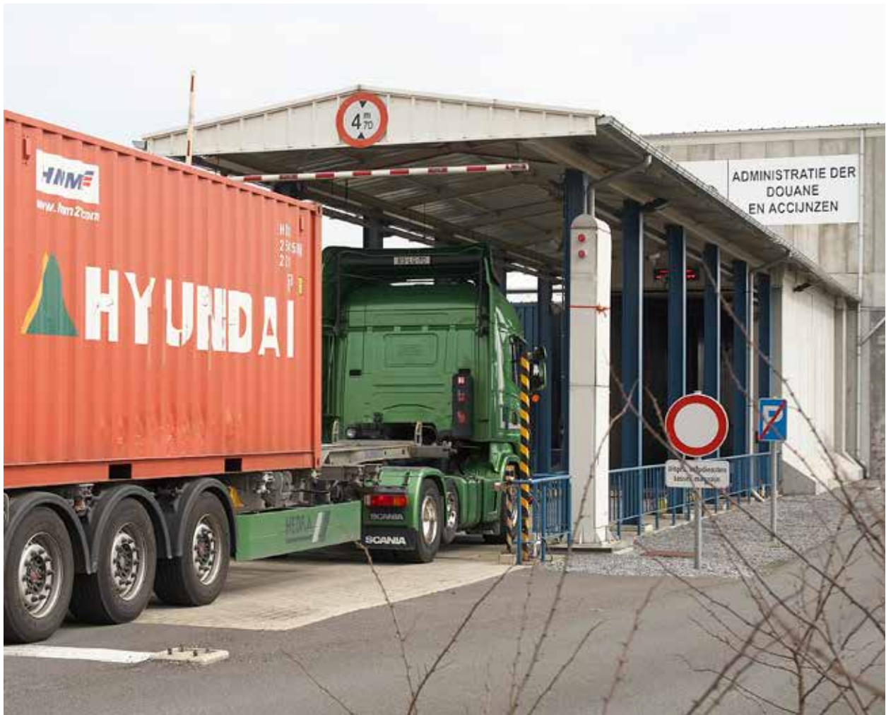
Een meetpoort bestaat uit twee verticale detectors die geplaatst worden aan weerszijden van de weg waarlangs voertuigen de site binnenrijden.
