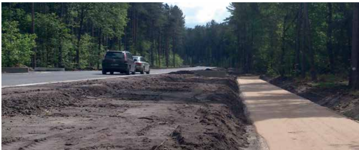
Langs de ontsluitingsweg werd ook een fietspad aangelegd.
