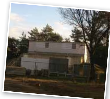
NIRAS bouwde een deel van een bergingsmodule op ware grootte na.
