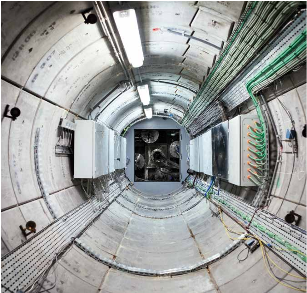
L'expérience de chauffe PRACLAY dans le laboratoire souterrain HADES
