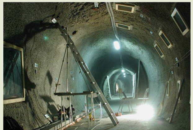
Travaux dans le laboratoire de recherche souterrain du Mont Terri, construit dans l'argile, en Suisse (source : Nagra).
