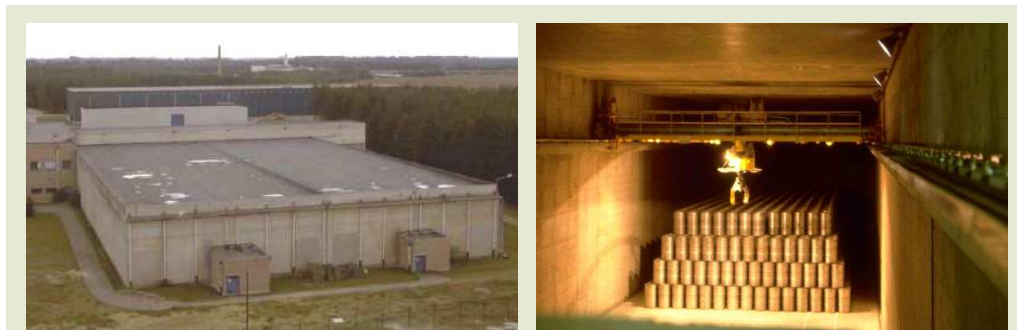
Figure 15 – Vue extérieure du bâtiment 127 de l'ONDRAF exploité par Belgoprocess, destiné à l'entreposage de déchets conditionnés de moyenne activité, et vue intérieure d'un de ses quatre bunkers. Les déchets sont manipulés grâce à un pont roulant commandé à partir d'une salle de commande séparée (source : Belgoprocess).
