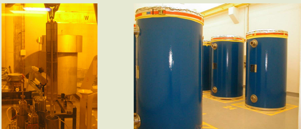
Figure 8 – Déchargement à Belgoprocess des combustibles irradiés du réacteur de recherche Thétis de l' Universiteit Gent (source : Belgoprocess) et entreposage de combustibles irradiés du réacteur de recherche BR3 du SCK•CEN dans des conteneurs Castor sur le site BP1 de l'ONDRAF exploité par Belgoprocess (source : Belgoprocess/ONDRAF).
