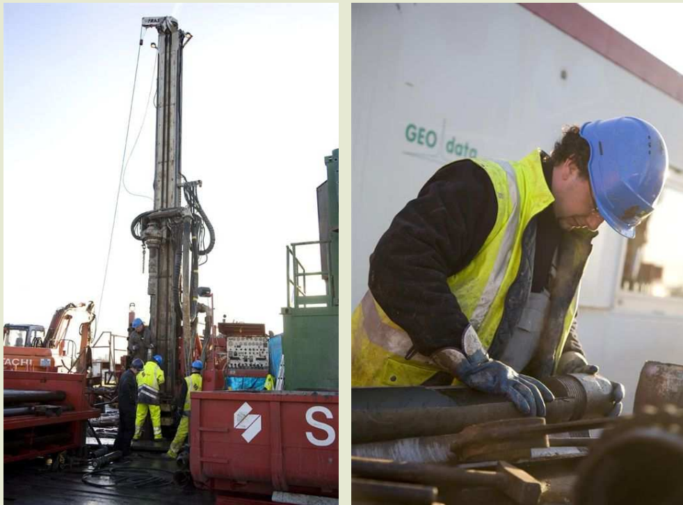
Figure 43 – Forage de reconnaissance et carottage pour les Argiles Yprésiennes à Kallo.
