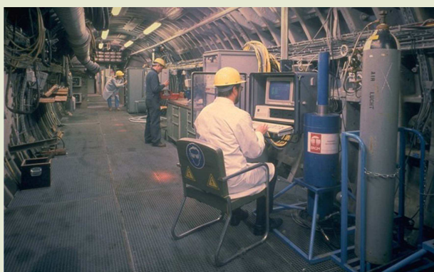
Première galerie de HADES
