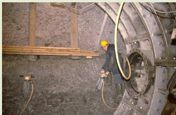
Creusement et pose du revêtement de la première galerie de HADES
