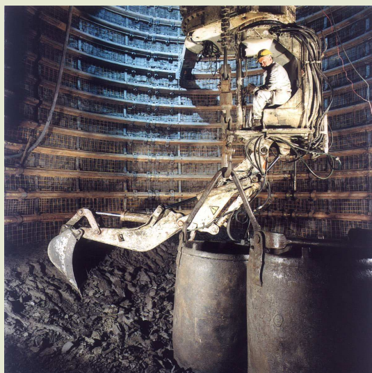
Construction du second puits
