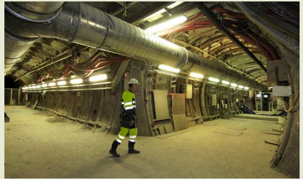
Vue du laboratoire de recherche souterrain de Meuse / Haute-Marne construit en France dans l'argile (source : Andra).
