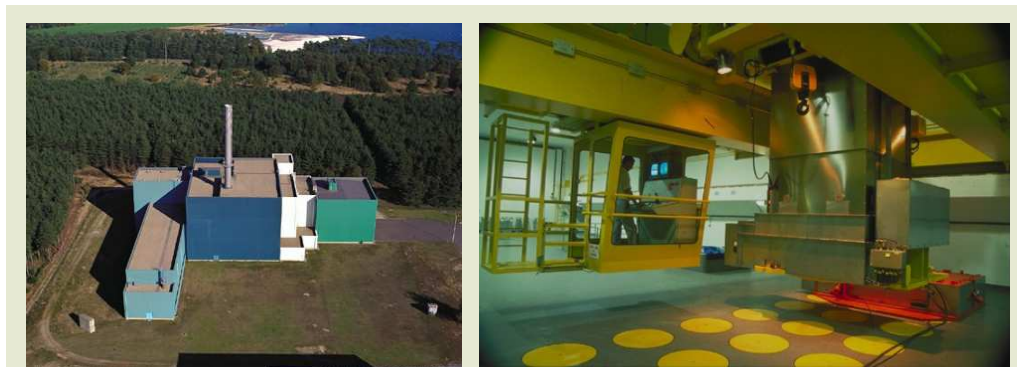
Figure 16 – Vues extérieure et intérieure du bâtiment 136 de l'ONDRAF exploité par Belgoprocess, destiné à l'entreposage de déchets conditionnés de haute et moyenne activités. Ce bâtiment a été conçu pour résister à des conditions externes extrêmes, comme des séismes, explosions ou chutes d'avions militaires. Les conteneurs de déchets de catégorie C, qui y sont manipulés à distance à partir d'une salle de commande blindée, sont empilés dans des silos équipés d'un système de ventilation destiné à évacuer la chaleur qu'ils dégagent. Par conteneur de 450 kg, cette chaleur est initialement comparable à celle d'un radiateur électrique domestique d'une puissance de 2 000 W (source : Belgoprocess).
