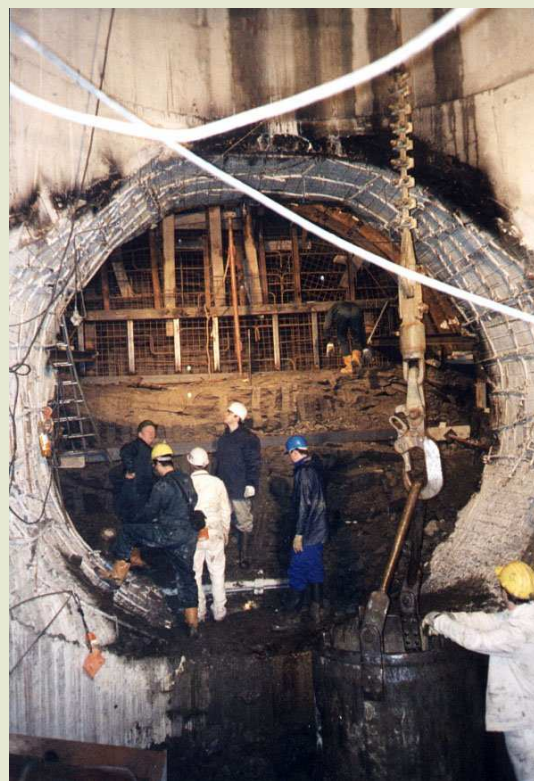
Construction de la chambre au bas du second puits
