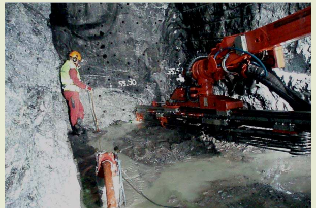
Travaux dans l'installation de caractérisation ONKALO, en Finlande (source : Posiva).
