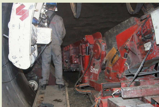
Construction de la galerie de liaison au moyen d'un tunnelier
