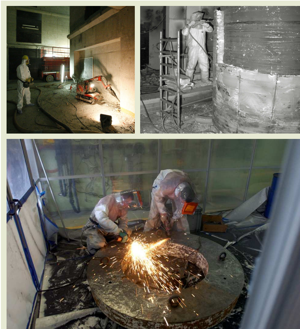
Figure 19 – En haut : démantèlement de l’usine-pilote de retraitement Eurochemic (source : Belgoprocess et Bonsei Publicatiebureau) ; en bas : démantèlement d’une pièce du réacteur de recherche BR3 (source : SCK•CEN).
