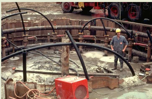
Congélation du sol en vue de la construction du premier puits
