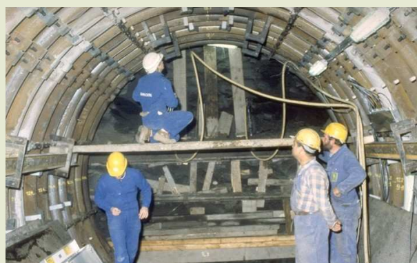
Pose du revêtement de l'extrémité de la deuxième galerie, dite « Test Drift »
