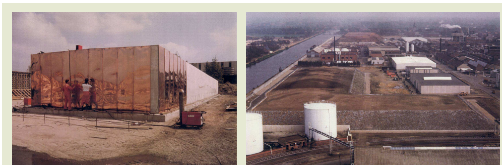
Figure 48 – L'installation autorisée d'entreposage provisoire UMTRAP d'Umicore à Olen. A gauche : placement du confinement en cuivre sur une casemate en béton ; à droite : vue générale du site après placement des couvertures (source : Umicore).
