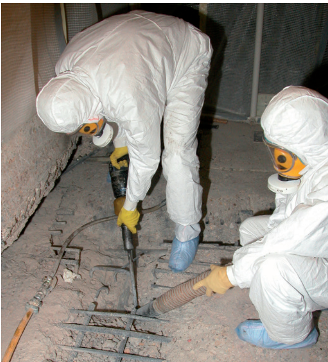
Ontmanteling van nucleaire installaties
